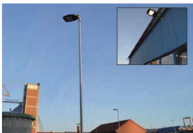
Очистные сооружения, Оснабрюк
