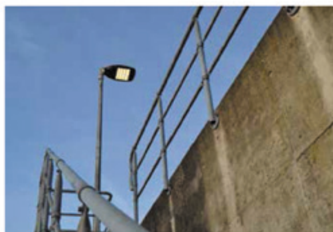
Очистные сооружения, Оснабрюк
